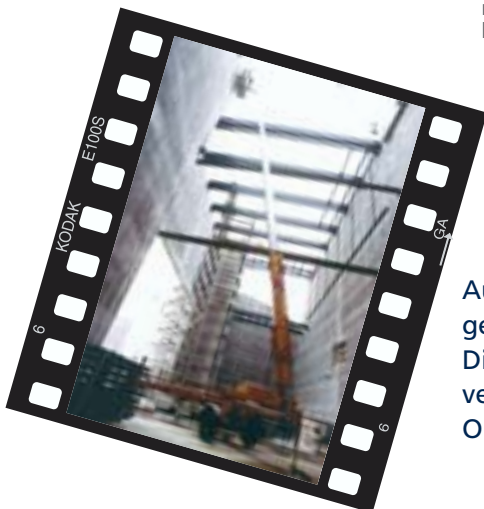
Fa. Berteit beim Neubau des NOKIA-Gebäudes in Bochum.
