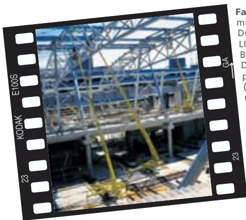
Fa. Prangl beim Umbau der Wiener Stadthalle mit einem DENKA-LIFT 2500 und im Hintergrund zu sehen einem DENKA-LIFT 1800.
