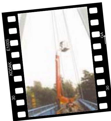
BT Zeilinga DL 19 N auf Fußgängerbrücke in Berlin
