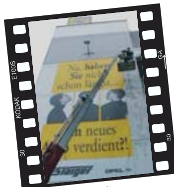
Danker, Brahmstedt Reinigungs- und Konservierungsarbeiten mit einem DENKA•LIFT 1800, hier an einem OPEL-Autohaus in Waiblingen.
