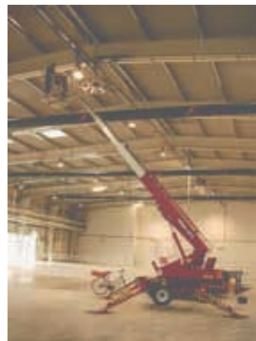
Im Arbeitskorb steht Herr Jöhnck (Elektriker).
